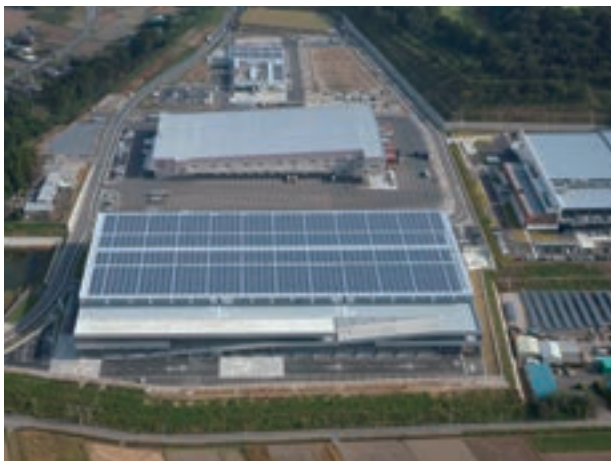
太陽光発電設備を備えたSGリアルティ東松山
