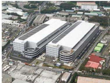
太陽光発電設備を備えているSGリアルティ柏
